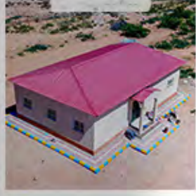
المبنى الإداري ARC OFFICES
